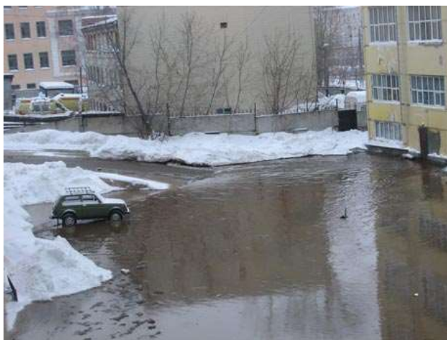
Рис. 6.2. Затопление дворовой территории при аварии на канализационных сетях
