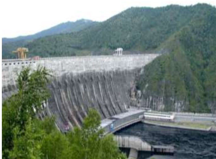
Рис. 4.1. Внешний вид плотины
