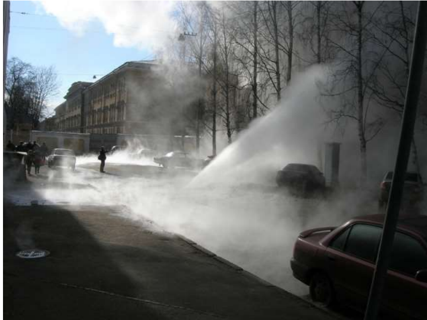
Рис. 6.6. Прорыв трубопровода на теплотрассе высокого давления
