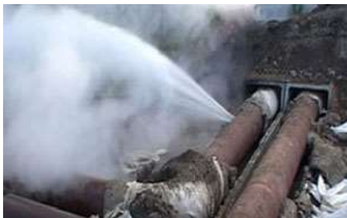
Рис. 6.1. Разрыв трубопровода высокого давления
