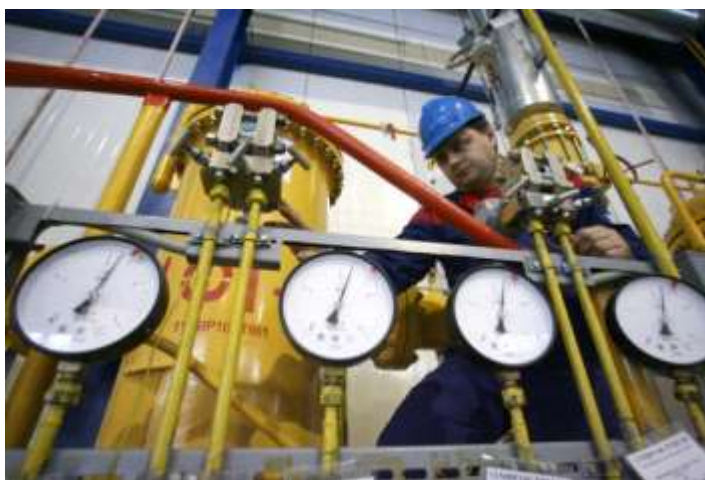
Рис. 6.3. Устранение аварии на системах газоснабжения
